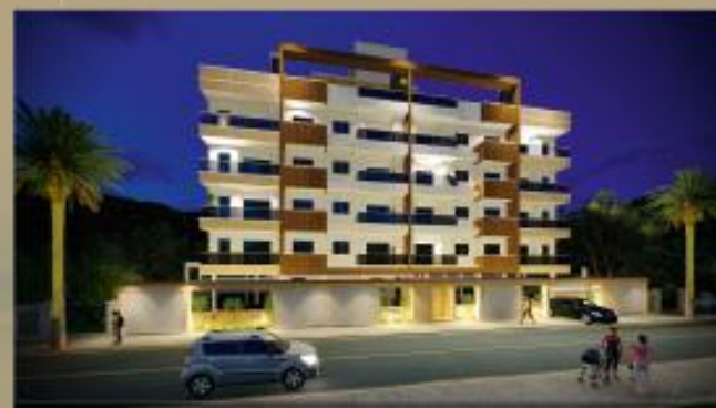
RUA MARTIN PESCADOR - BOMBAS
